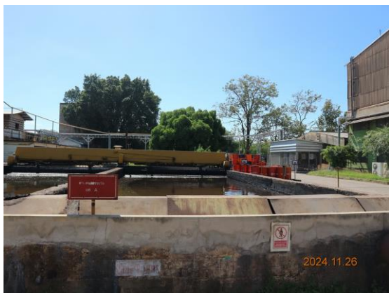
รูปที่ 3.6 บ่อดักคราบน้ำมันและจาระบีภายในโครงการ
